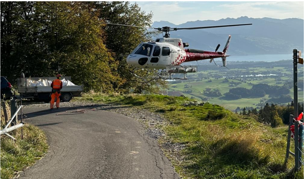
Abtransport vom Eternit des Stallanbaus Salzmatt (Sondermüll)
