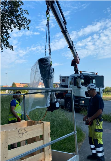
Einbau Pumpe beim Schacht Zollhaus
