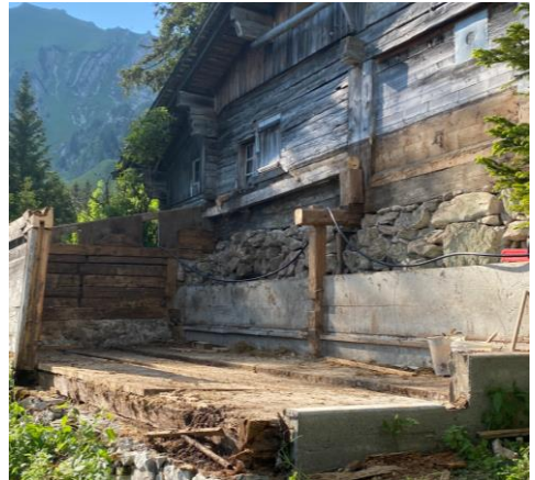
... und nach dem Rückbau
