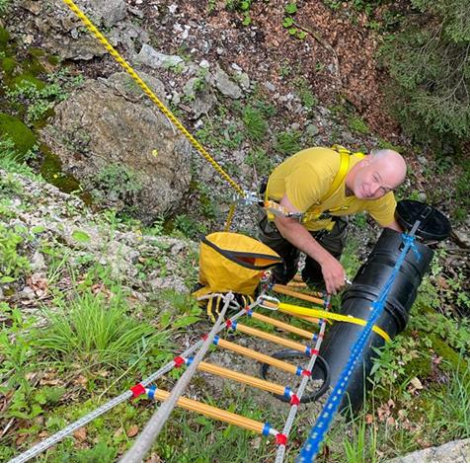
Froschklappenmontage beim KW Schneeweid
