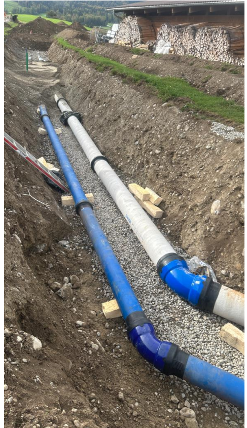
Neue Transportleitungen Thunstrasse Blumenstein
