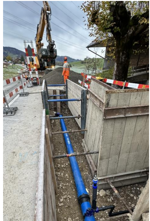
Leitungsbau in der Kantonsstrasse
