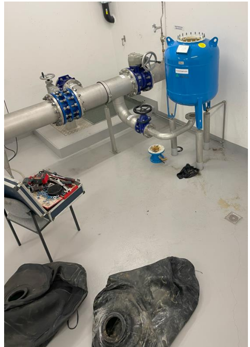
Wartung der Druckschlagdämpfer
