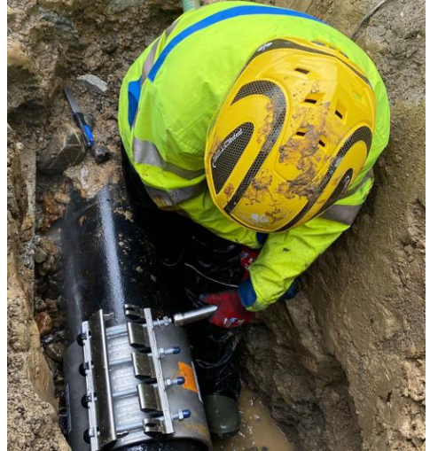
André montiert die RepaFlex unter Druck
