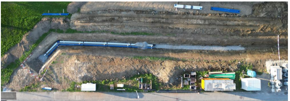
Leitungsverlegung im Kulturland hinter dem Insatallationsplatz (DN300 weiss, DN200 blau)
