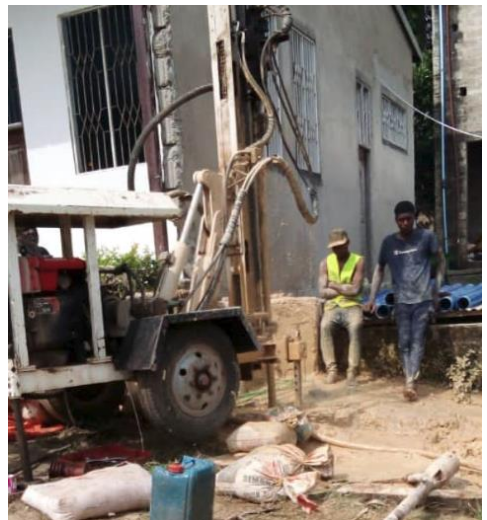
Bohrung des neuen Brunnens
