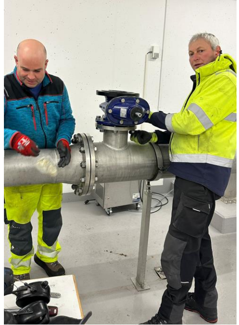
Montage des Be-/Entlüftungsventils
