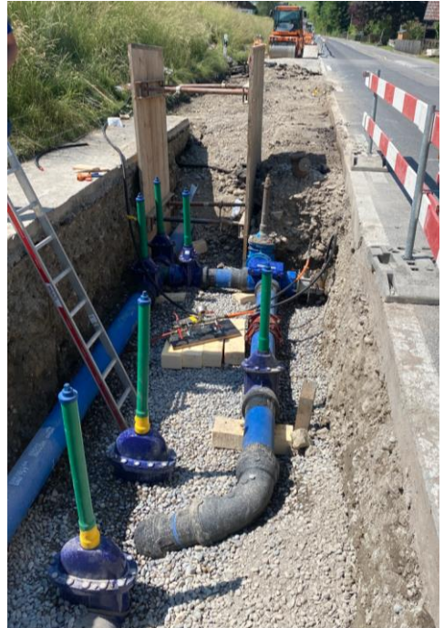
Abgangsleitung Richtung Wattenwil mit Notverbindung DN200-DN300
