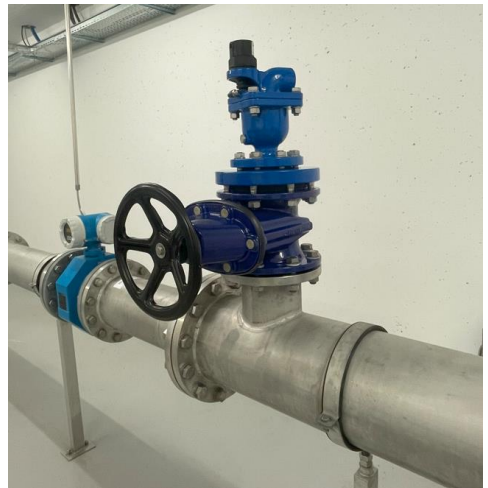
Montage des Be-/Entlüftungsventils
