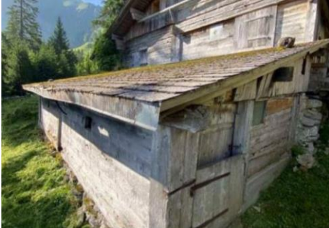
Angebauter Geissenstall vor dem Rückbau
