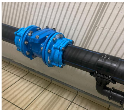
Einbau von Rückflussverhinderern
