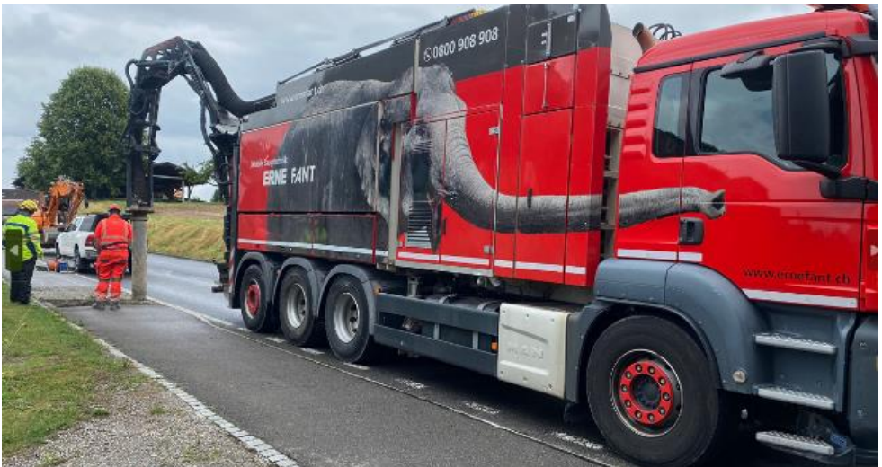
Saugbagger im Einsatz
